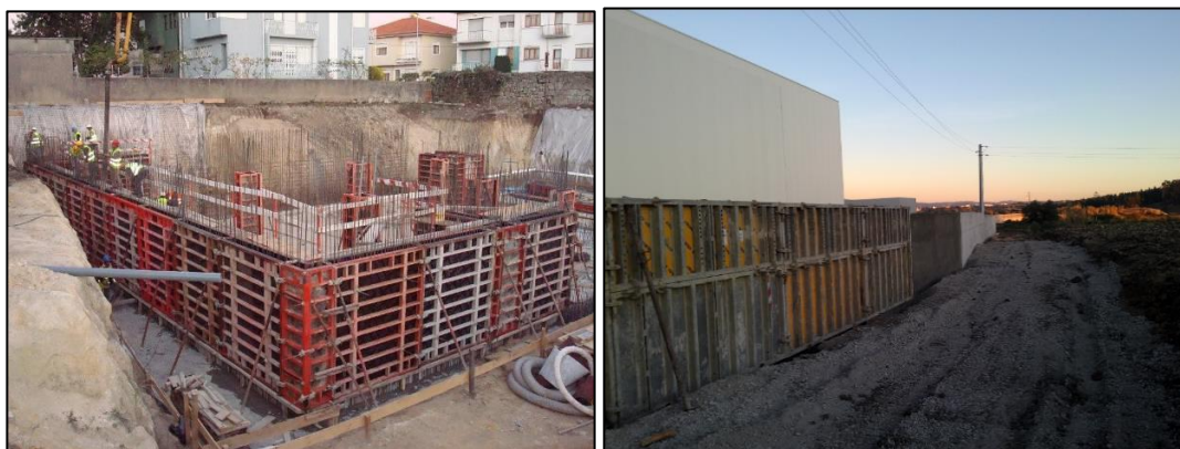
Figura 25 – Cofragem de muros
