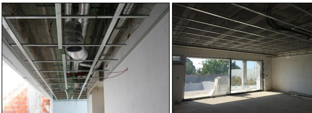
Figura 42 – Estrutura de suporte do teto falso e infraestruturas existentes antes da placagem
