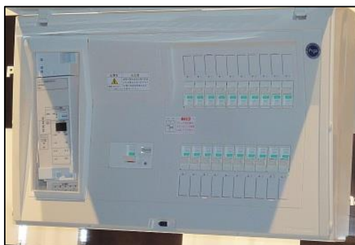
Figura 52 - Quadro elétrico
