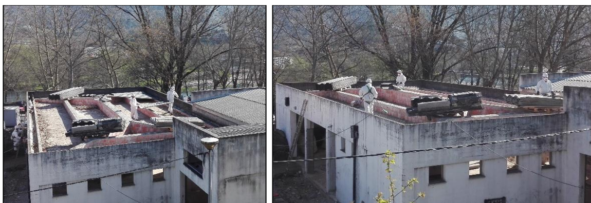
Figura 11 –Remoção das chapas
