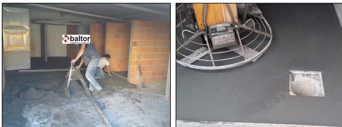
Figura 41 – Execução betonilha de regularização e afagamento
