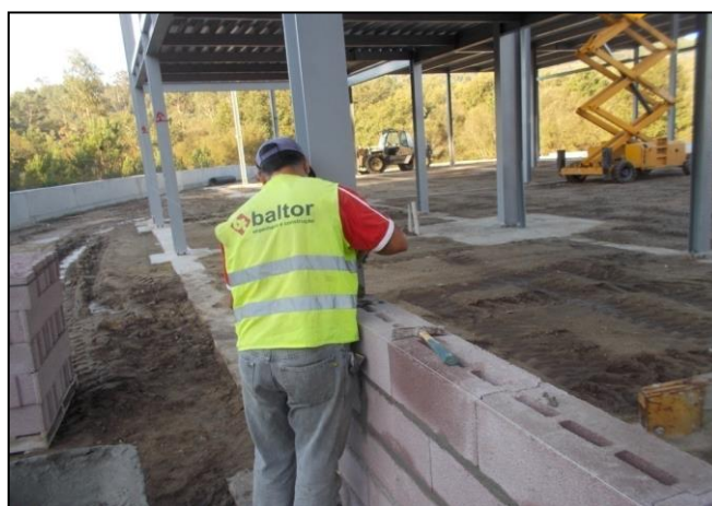
Figura 34 – Assentamento de alvenaria em bloco
