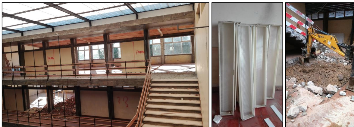
Figura 9 – Demolição de paredes, de pavimento e remoção de luminárias
