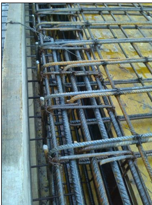
Figura 26 – Pormenor ferro em viga
