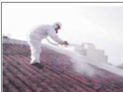
Figura 10 – Aplicação do aglutinante adequado para o amianto
