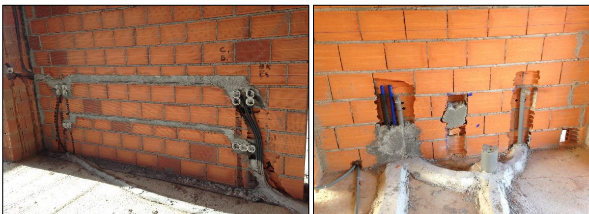
Figura 35 – Exemplo de roços nas especialidades de eletricidade e de redes hidráulicas
