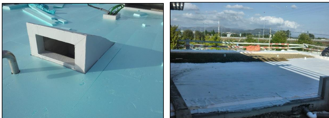
Figura 30 – Poliestireno extrudido e manta geotêxtil em cobertura
