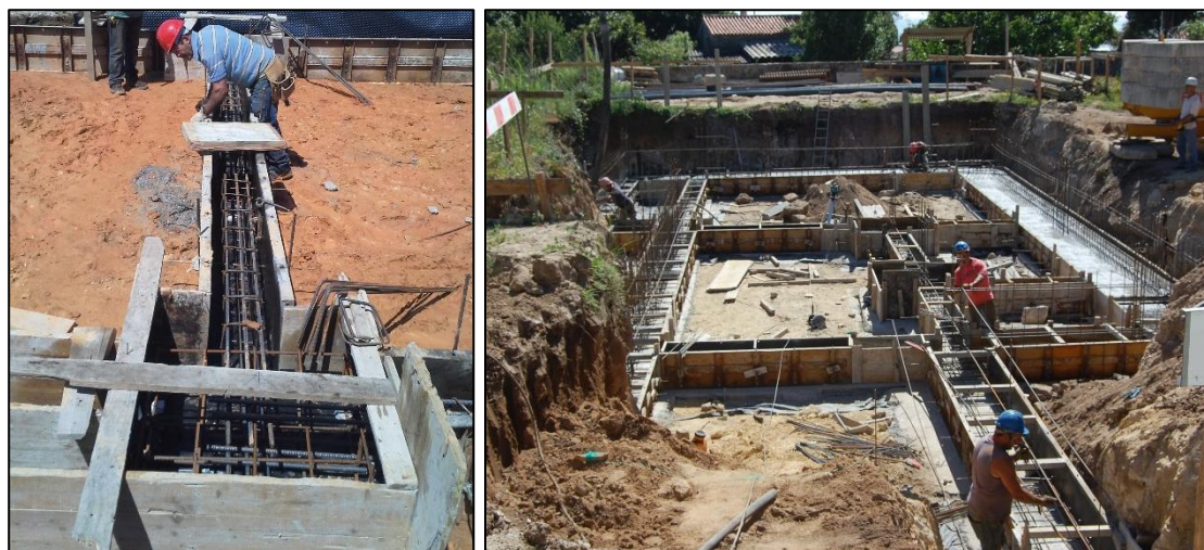
Figura 24 – Cofragem de sapatas e lintéis
