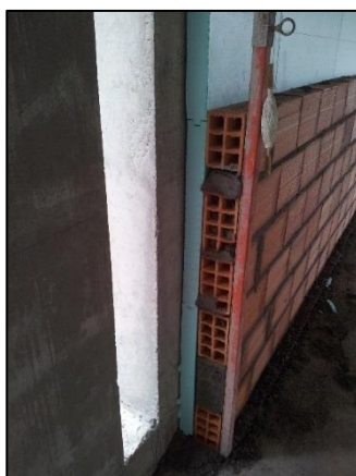
Figura 33 – Execução de alvenaria em tijolo
