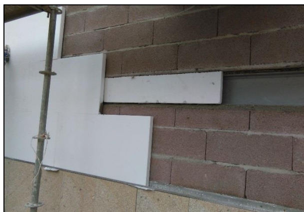
Figura 38 – Esquema da constituição do sistema ETICS
