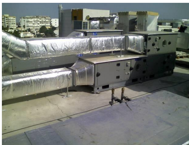
Figura 56 – Equipamento de ventilação mecânica
