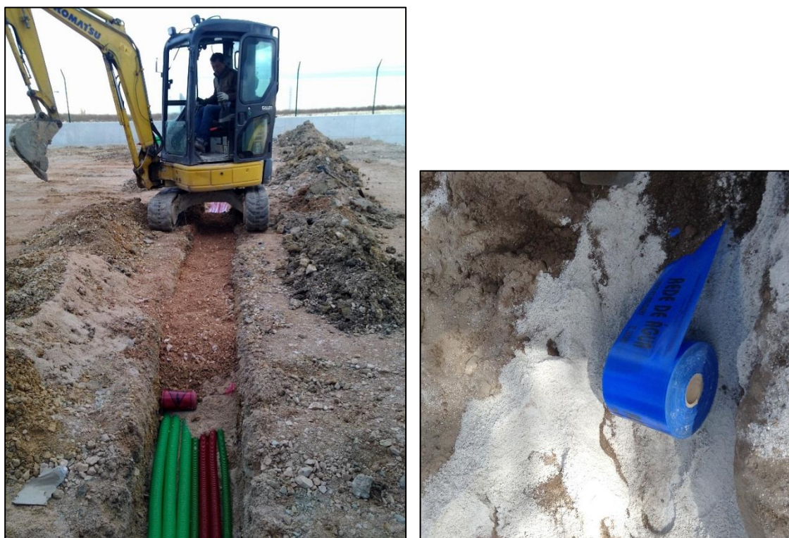
Figura 58 – Vala com colocação de tubagem
