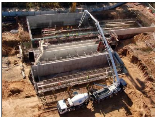
Figura 23 – Betonagem de betão através de bomba
