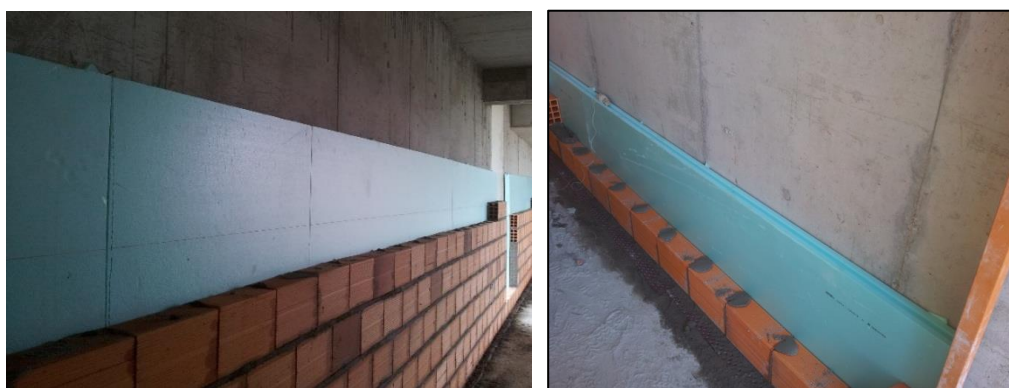
Figura 37 – Isolamento com xps em paredes
